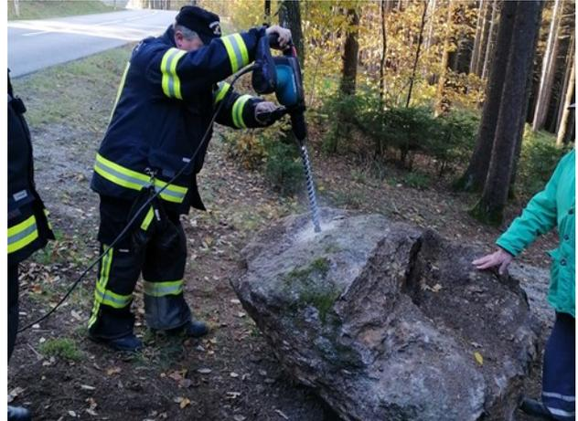
Wir setzten daher Quellsprengstoff ein, der seine Wirkung erst beim Aushärten entfaltet. Dadurch konnte der Stein schonend zerkleinert werden.
